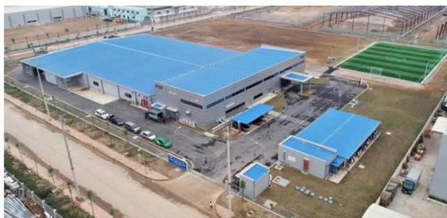
ベトナム新工場 延床面積約5800㎡の建屋
